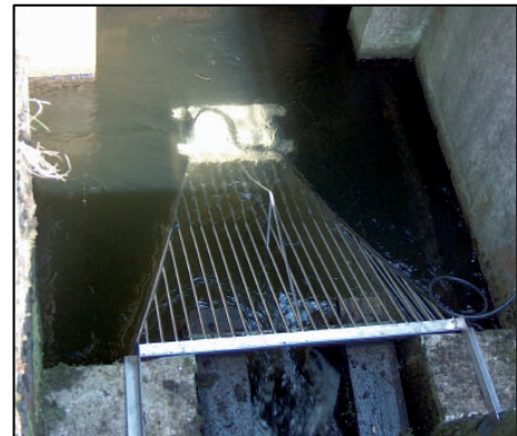
Figur 3. Fisketælleren i position i fisketrappens øverste kammer.
